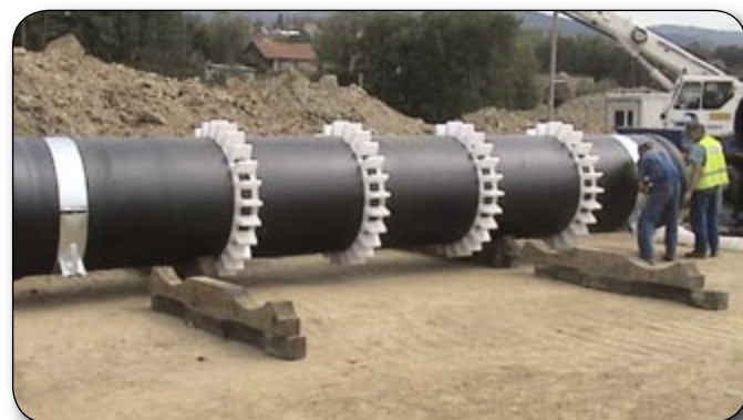
Montaż rurociągu DN1200 z żeliwa sferoidalnego w Bielsku-Białej
