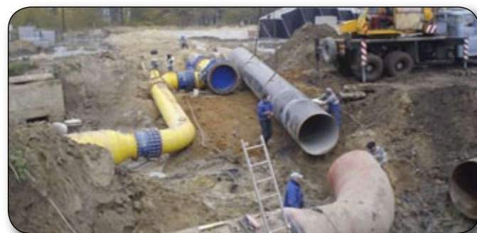
Montaż węzła rurociągu DN1400, DN1200
