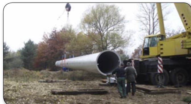
Przebieżenie rurociągiem DN1200 nad Czarną Przemszą
